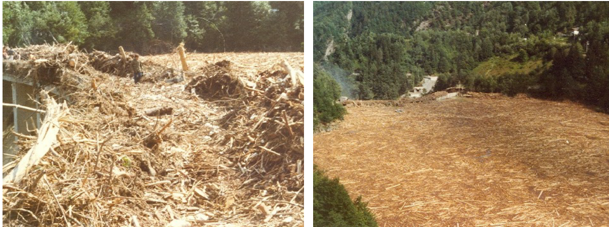
Figura 156: Diga di Palagnedra a seguito del maltempo nell'agosto 1978, da notare l'elevatissima quantità di materiale nel bacino (Polier, 2015).
